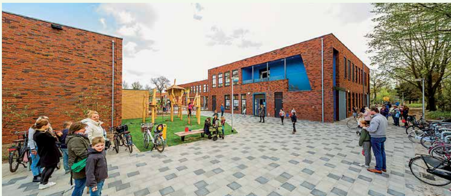
HET NIEUW GEBOUWDE MFC ATRIA BIEDT ONDERDAK AAN TWEE BASISCHOLEN, EEN BUITENSCHOOLSE OPVANG EN EEN GYMZAAL.
